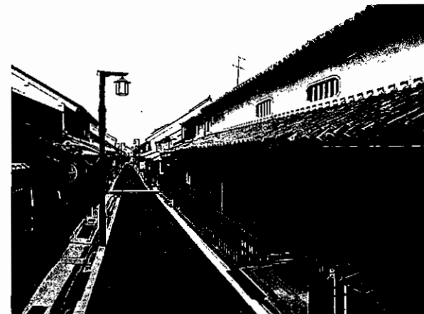
写真2 無電柱化された本町筋（自治体管路方式による無電柱化が進められている。歴みち事業とともに、町並みの印象は変化している。写真は、今西家の正面から東に通じる本町通りである。）
