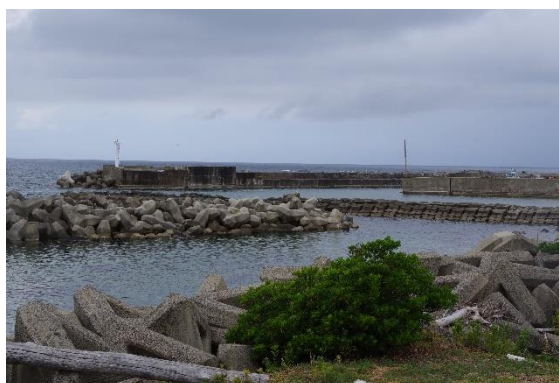
写真5 防波堤の被災状況
