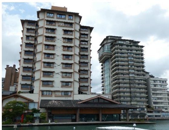
写真3 加賀屋の損害状況
