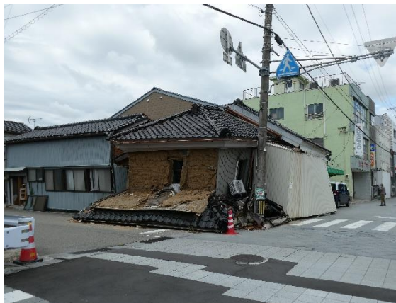
写真1 1階部分が倒壊している建物
