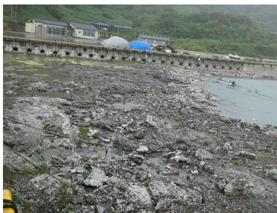
写真9 海底が露出している様子
