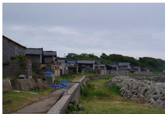
写真6 赤崎漁村の被災状況
