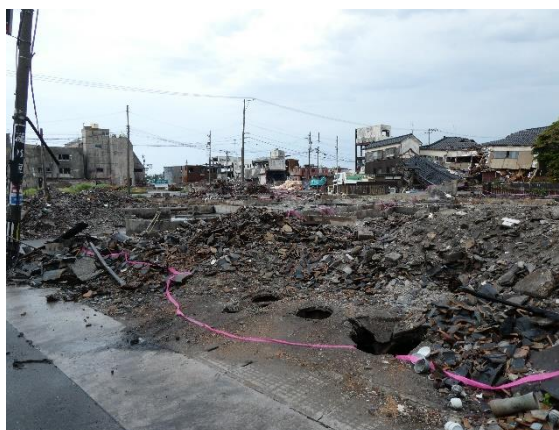
写真11 火災による倒壊した一面の様子 (その1)
