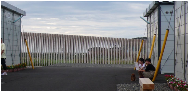
写真1 木製間垣のある仮設（上：間垣と仮設、下：内側の風景）
