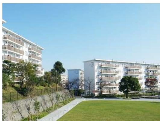
総合改修後の洋光台北団地
